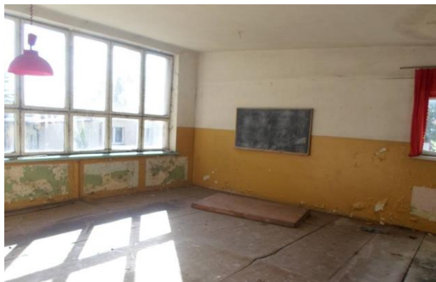
Zdjęcie 1. Budynek szkoły w Sądziecznie
